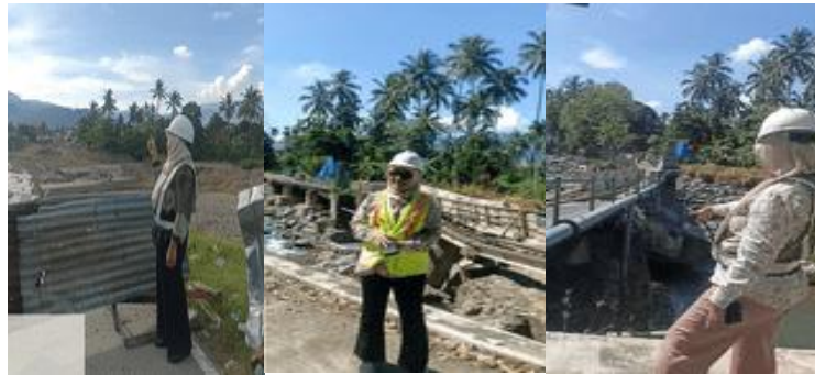
Gambar 2. Survey kondisi infrastruktur jalan dan jembatan ke Kecamatan Pauh, Kota Padang
