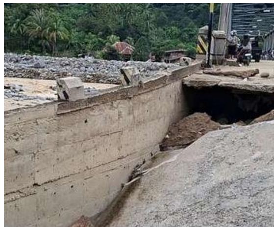
Gambar 5. Jembatan Koto Tuo
