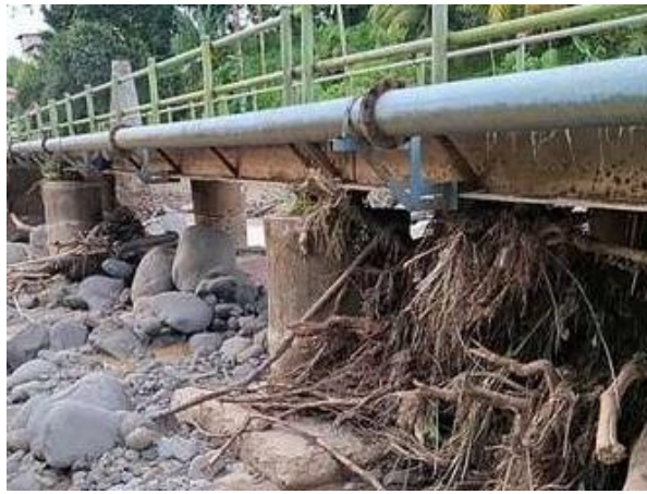
Gambar 4. Jembatan Koto Panjang Limau Manis
