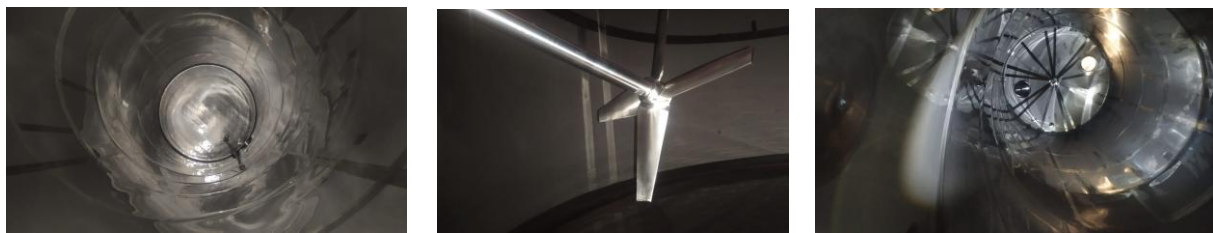
Gambar 3. Visual Check Silo.
