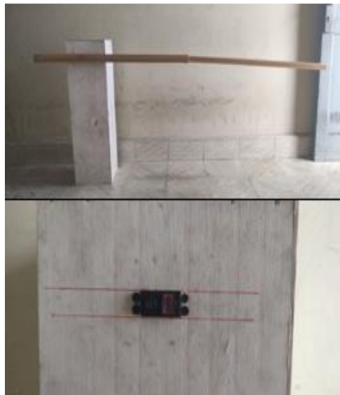
Gambar 10. Pelaksanaan Pembangunan Palang Pintu
