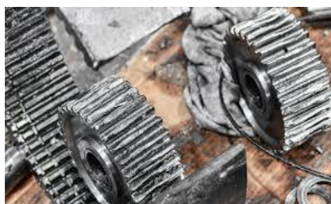
Gambar 4. kerusakan pada Gearbox
