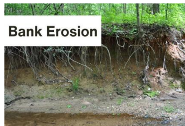
Gambar 5. Erosi sungai / saluran ( Bank Erosion )
